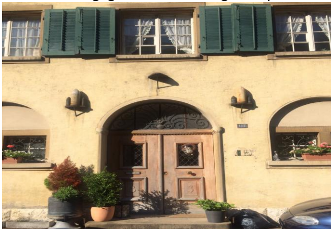
Verwaltungsbau der ehemaligen Sprengstofffabrik Cheddite, vom Abbruch bedroht
